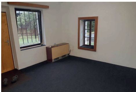
Vnitřek budovy po opravách
